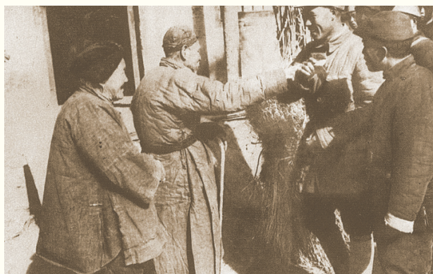
战士损坏了家具，向房东道歉赔偿，而房东坚决不收。
