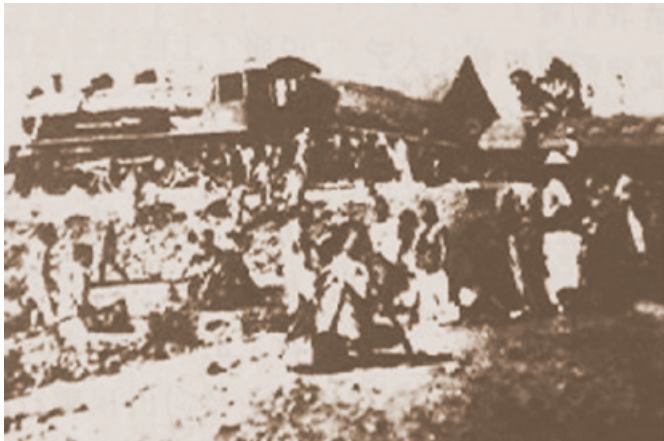
临城劫车案之脱轨列车
